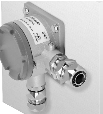
Рисунок 3.2 – Монтаж УЗИП (в корпусе ВР-12)
